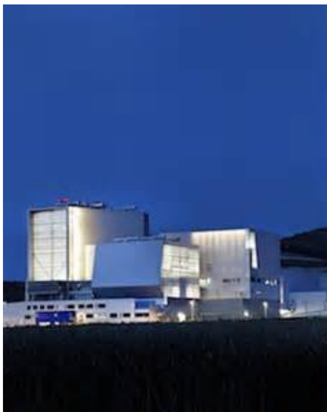
Pôle de traitement et valorisation Vernéa
